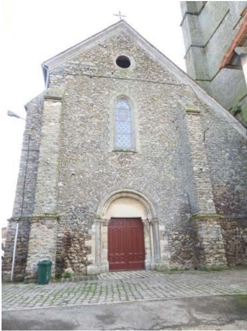
Façade ouest de l'édifice, enduits altérés, moellons de pierres déjointoyés en pied de mur, traces de remontées capillaires, présence de mousse et de lichen
