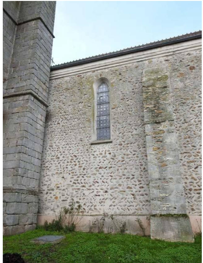
Opus Spicatum, disposition de pierres en épis de blé, ou en "arêtes de poisson"
