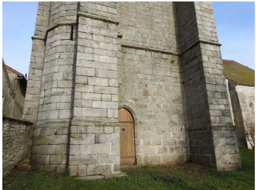
Détail des façades nord et sud, pierres appareillées déjointoyées, présence de mousse et de lichen
