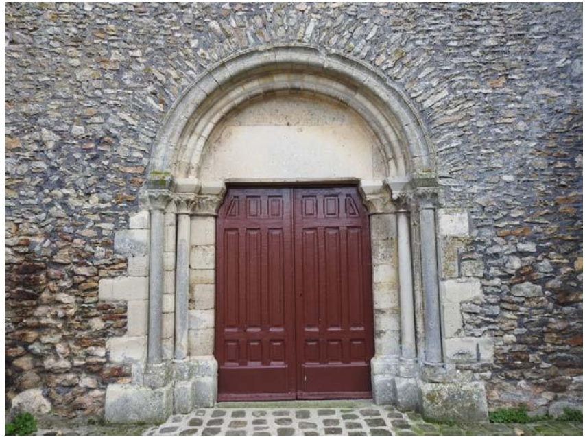
Façade ouest de l'édifice, enduits altérés, moellons de pierres déjointoyés en pied de mur, traces de remontées capillaires, présence de mousse et de lichen
