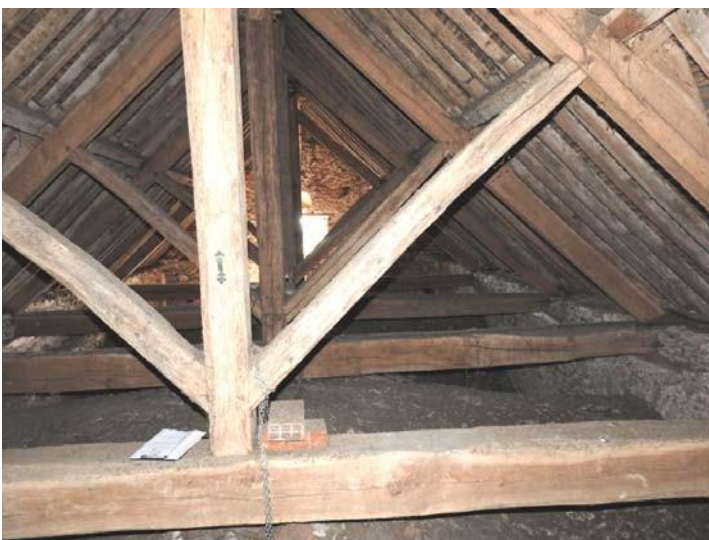
Charpente de la nef et du bas-côté
