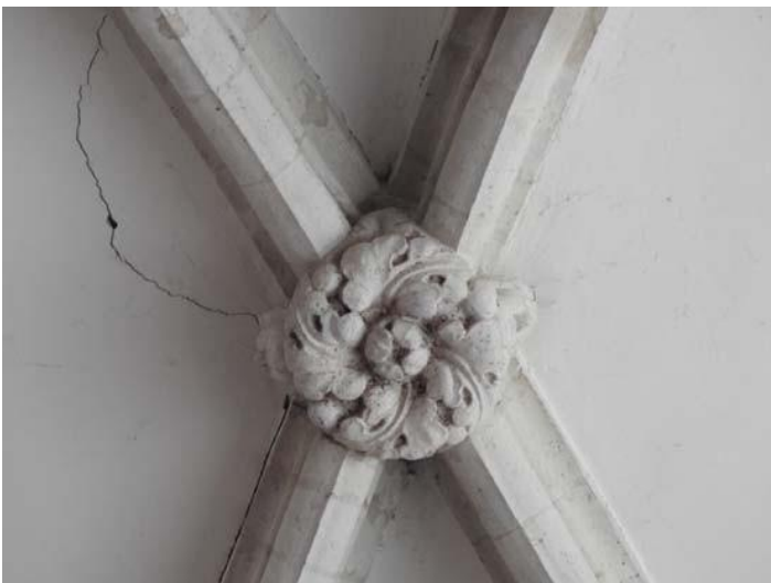
Détail des fissurations des voutains au droit de la clé de voûte et des départs de voûte
