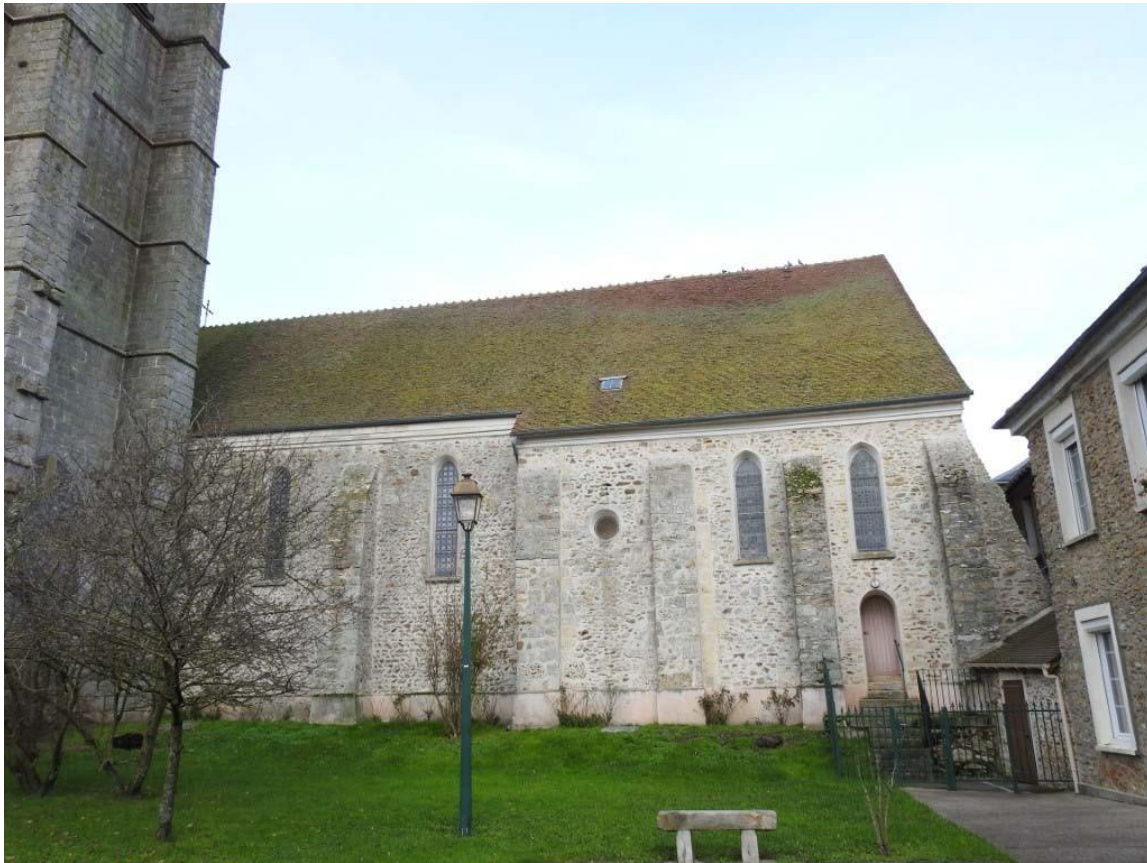
Façade sud de l'église
