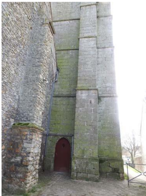
Détail des façades nord et sud, pierres appareillées déjointoyées, présence de mousse et de lichen
