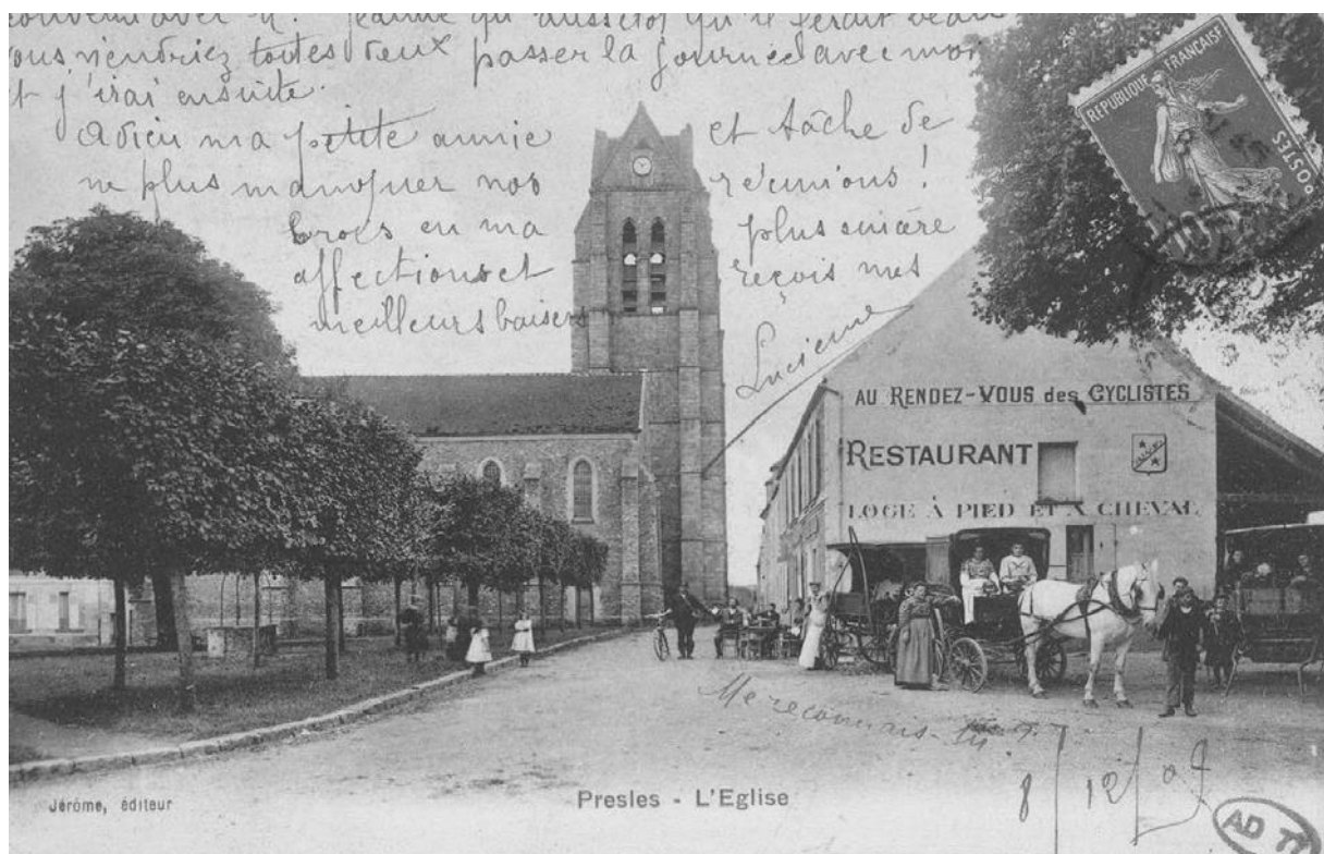
Photographie ancienne de la fin du XIXème, début du XXème siècle - Eglise de Presles-en-Brie – Façade nord
