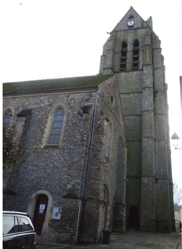
Façade sud du clocher et façade nord, pierres appareillées déjointoyées, présence de mousse et de lichen
