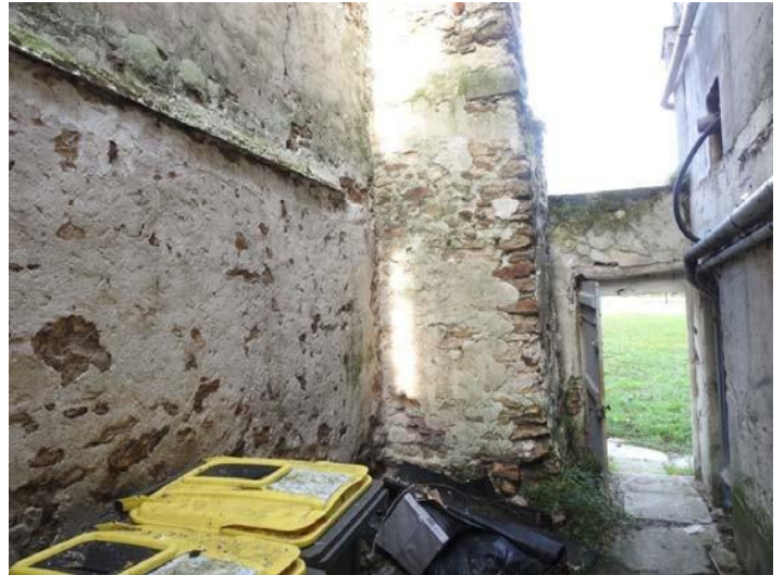
Façade est de l'édifice, enduits altérés, moellons de pierres déjointoyés, Soubassement dégradé, présence de mousse et de lichen
