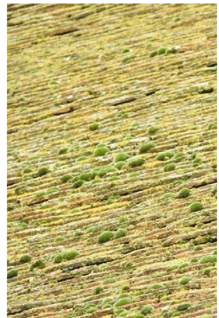
Couverture de la nef et du chœur altérée, tuiles ponctuellement manquantes et brisées, tuiles poreuses – couverture recouverte de mousses
