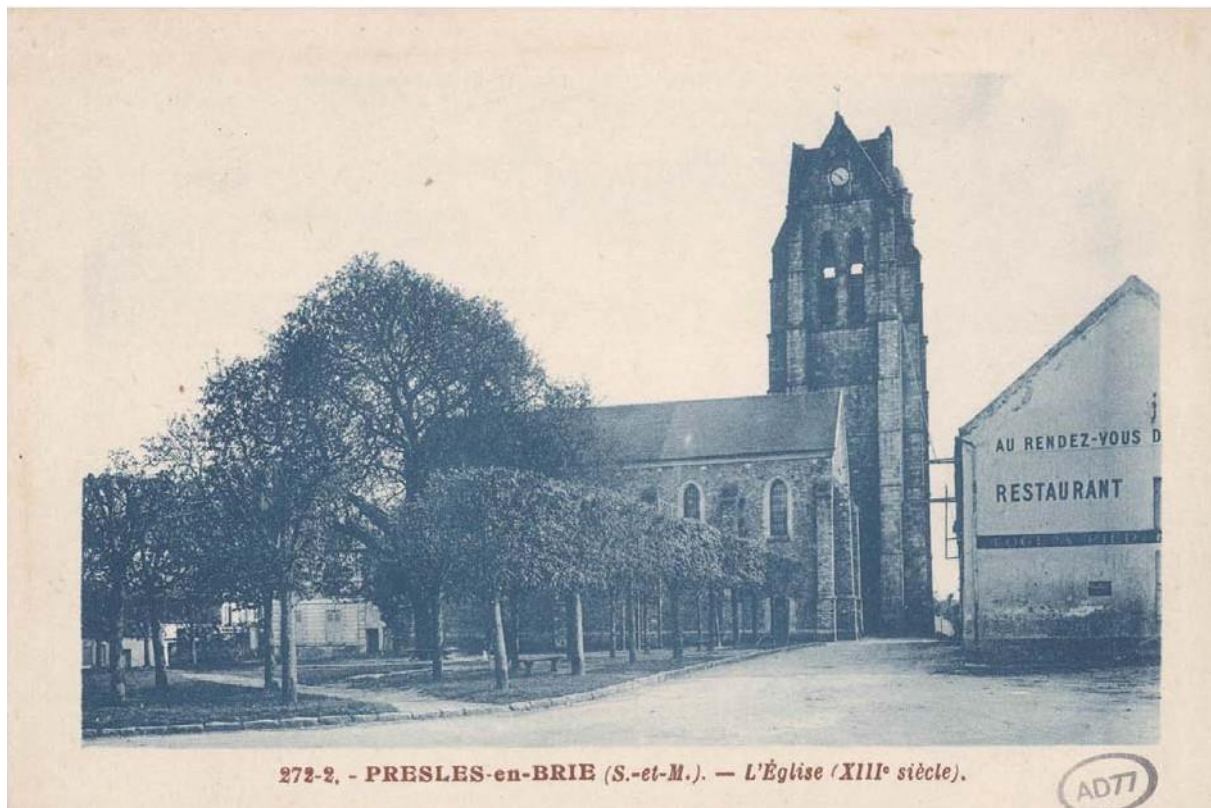
Photographie ancienne de la fin du XIXème, début du XXème siècle - Eglise de Presles-en-Brie – Façade nord
