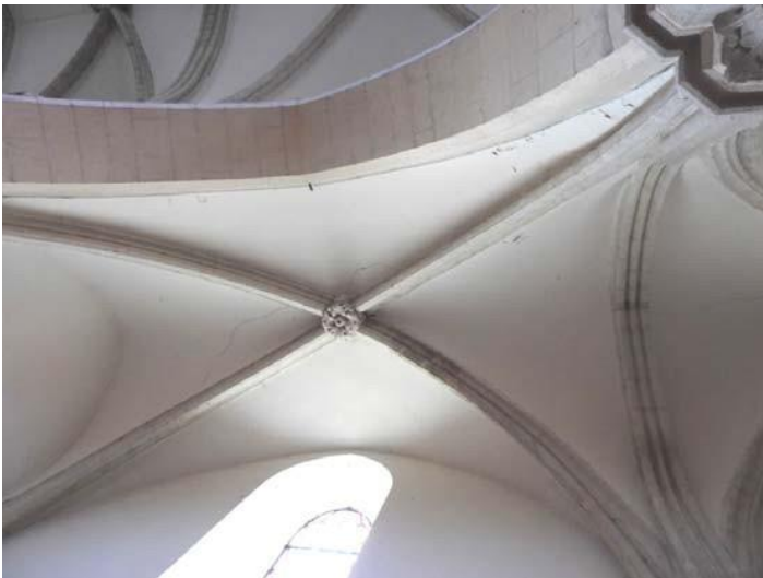
Fissuration des voutains du bas-côté sud
