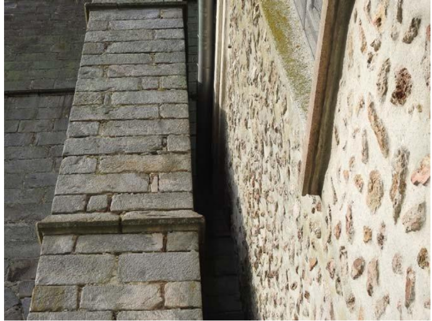
Détail des façades du clocher, pierres appareillées déjointoyées, présence de mousse et de lichen
