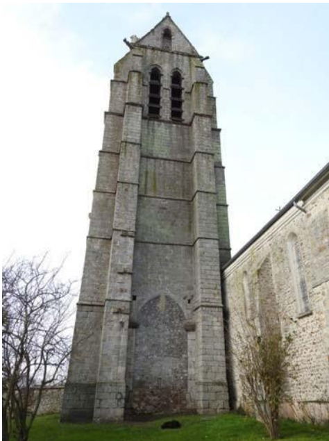
Façades est et ouest du clocher, pierres appareillées déjointoyées, présence de mousse et de lichen
