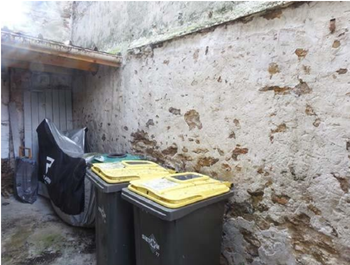
Façade est de l'édifice, enduits altérés, moellons de pierres déjointoyés, Soubassement dégradé, présence de mousse et de lichen
