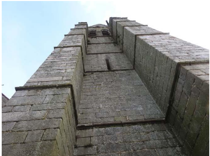
Façades est et ouest du clocher, pierres appareillées déjointoyées, présence de mousse et de lichen
