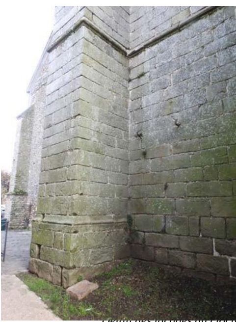
Détail des façades du clocher, pierres appareillées déjointoyées, présence de mousse et de lichen
