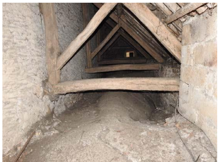
Charpente de la nef et du bas-côté
