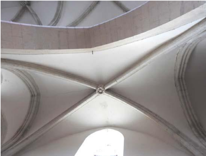
Fissuration des voutains du bas-côté sud
