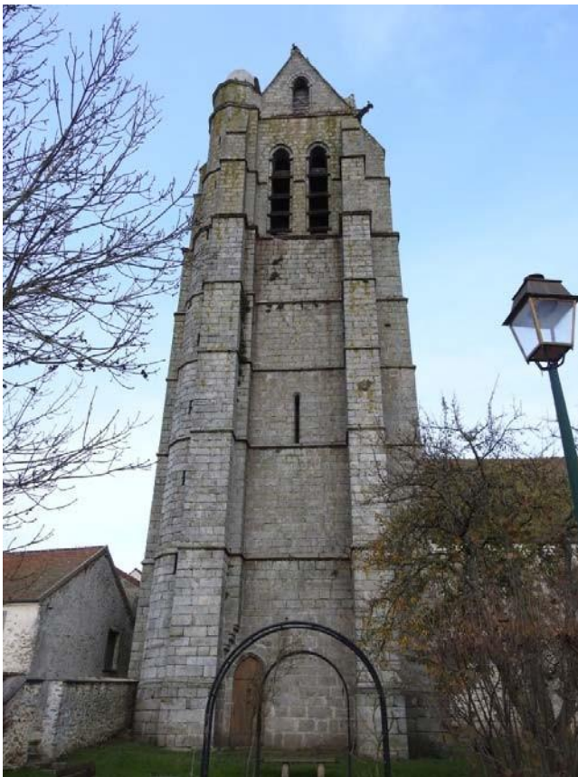
Façade sud du clocher et façade nord, pierres appareillées déjointoyées, présence de mousse et de lichen
