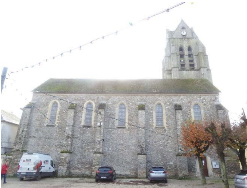
Couverture de la nef et du chœur altérée, tuiles ponctuellement manquantes et brisées, tuiles poreuses – couverture recouverte de mousses
